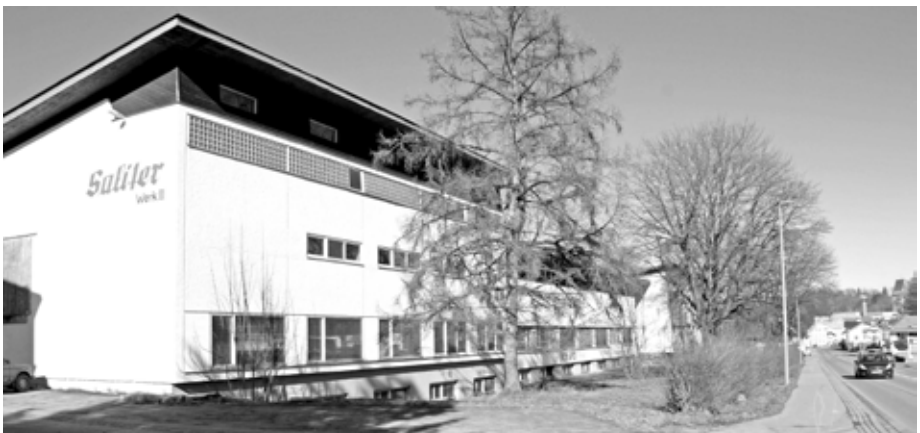
Nach Abbruch des Werksgebäudes sollen dort im Rahmen eines Projekts „Wohnanlage Schloßfeldweg“ hochwertige Wohnungen mit einer Tiefgarage entstehen. Fotos: Hermann Knauer
